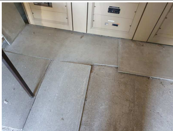
Déclaré - : SITE 05 LA CHANTRERIE / BATIMENT ISITEM / RDC / H019 - Dalle de sol - EP- (Présence d'amiante)
