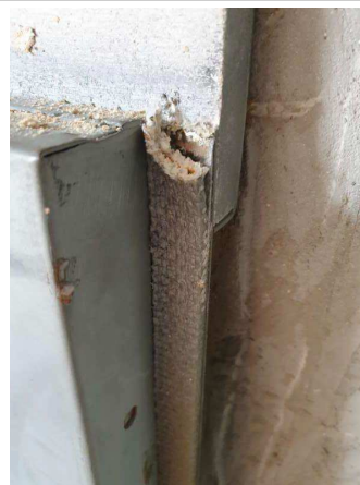
Prélèvement - P008 : SITE 05 LA CHANTRERIE / BATIMENT ISITEM / R+3 / LOCAL CTA - Joint de porte - EP- (Présence d'amiante)
